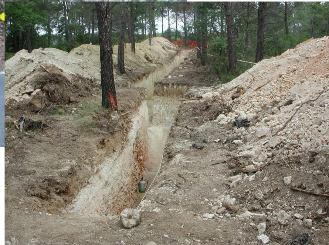
Tranchée creusée pour l'étude de la paléosismicité, Ganay, route de Puyricard à Rognes (D14), photo O. Bellier.
